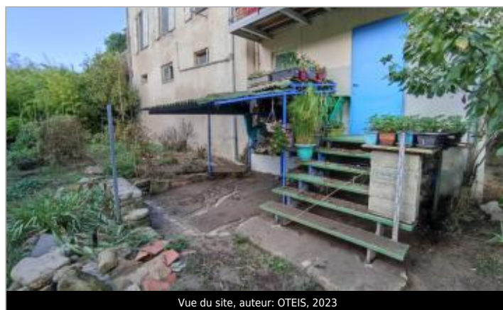
Vue du site, auteur: OTEIS, 2023
