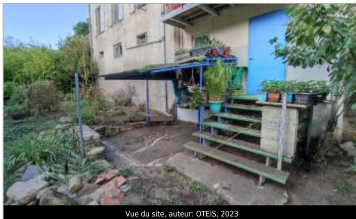
Vue du site, auteur: OTEIS, 2023
