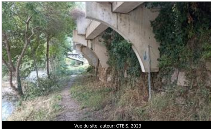
Vue du site, auteur: OTEIS, 2023
