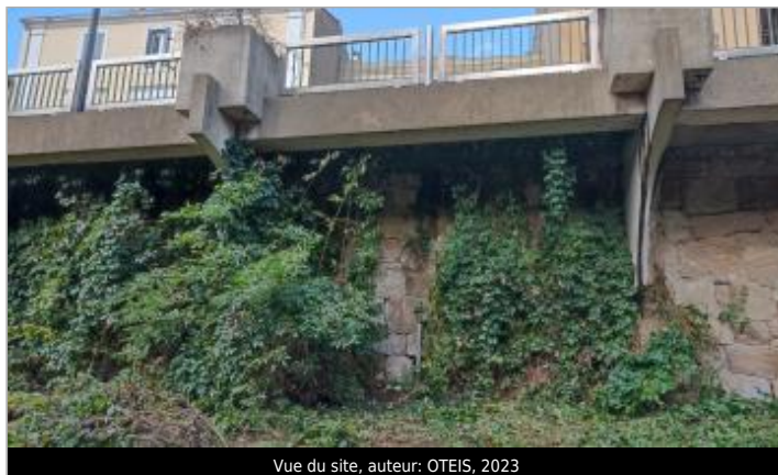
Vue du site, auteur: OTEIS, 2023
