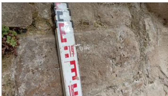
Vue du repère, auteur: OTEIS, 2023
