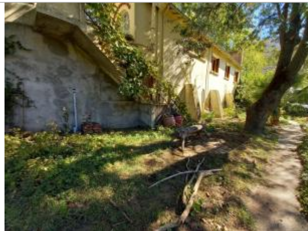
Vue du site, auteur: OTEIS, 2023
