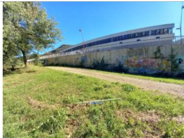
Vue du site, auteur: OTEIS, 2023
