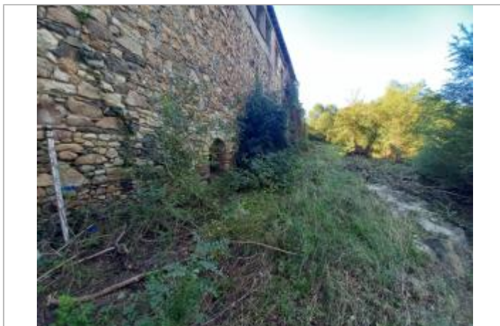
Vue du site, auteur: OTEIS, 2023
