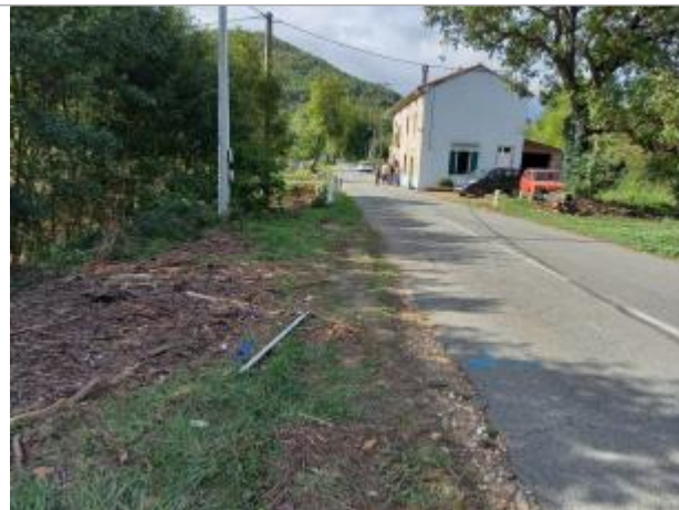
Vue du site, auteur: OTEIS, 2023
