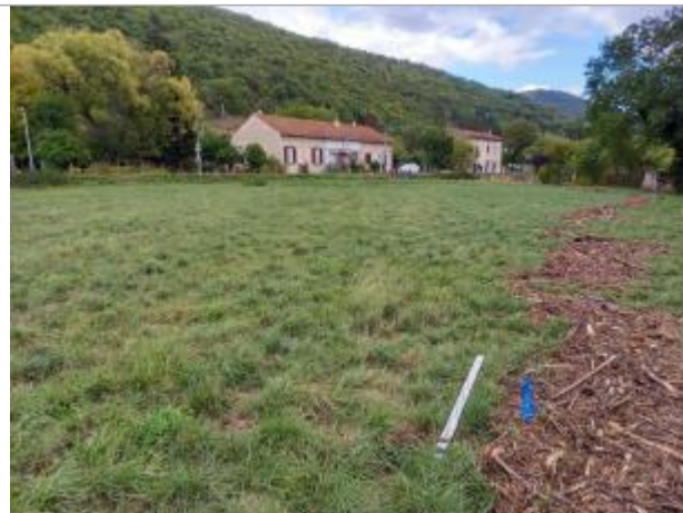
Vue du site, auteur: OTEIS, 2023
