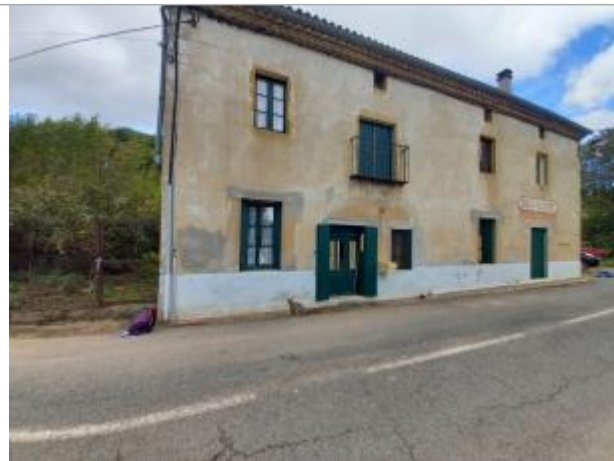
Vue du site, auteur: OTEIS, 2023
