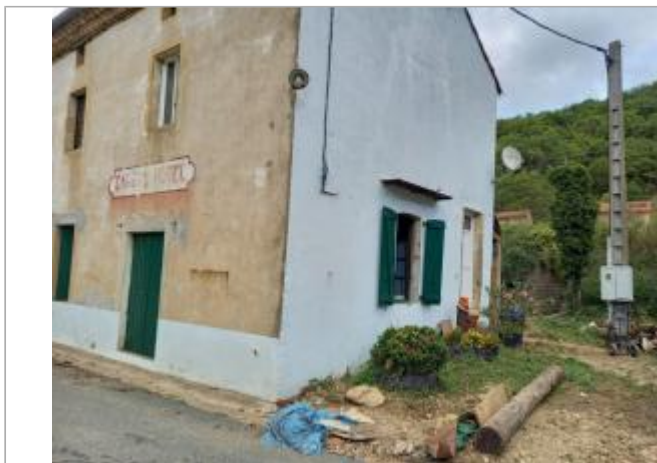
Vue du site, auteur: OTEIS, 2023
