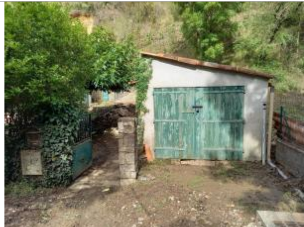
Vue du site, auteur: OTEIS, 2023
