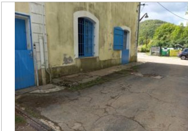
Vue du site, auteur: OTEIS, 2023
