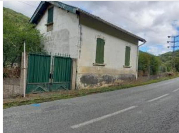
Vue du site, auteur: OTEIS, 2023
