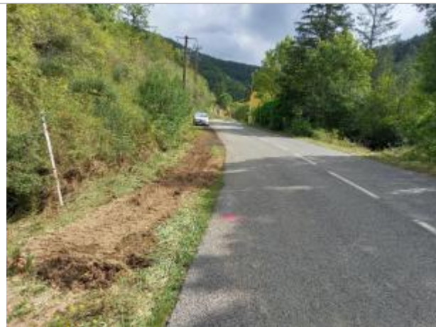
Vue du site, auteur: OTEIS, 2023
