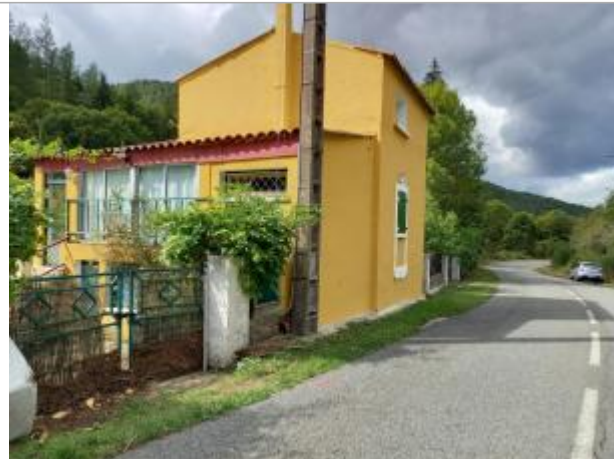
Vue du site, auteur: OTEIS, 2023
