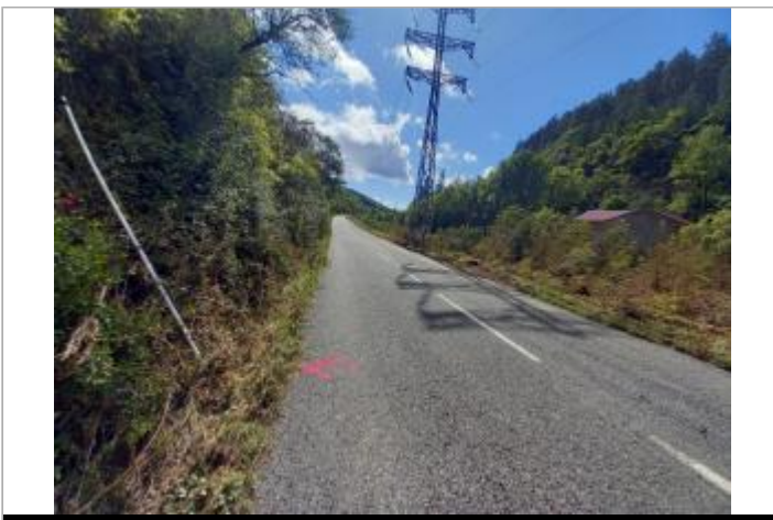
Vue du site, auteur: OTEIS, 2023
