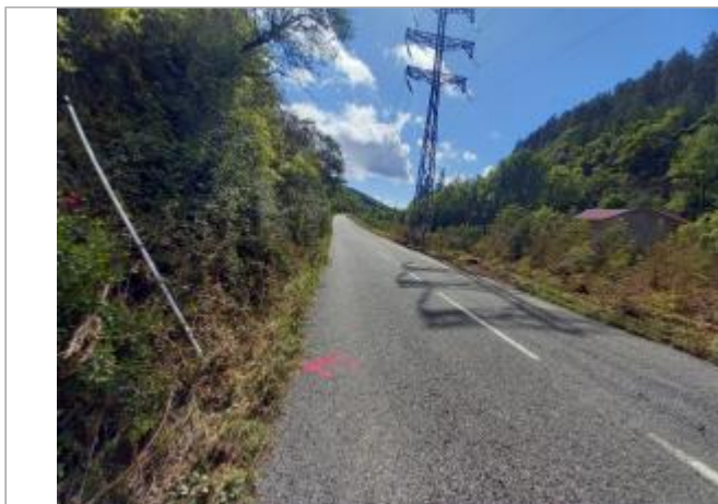
Vue du site, auteur: OTEIS, 2023
