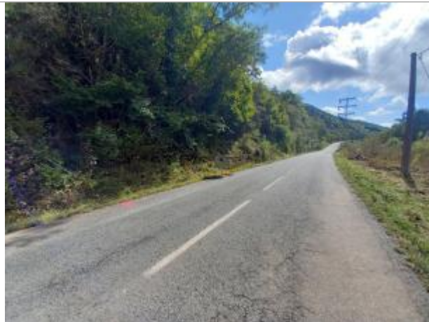
Vue du site, auteur: OTEIS, 2023
