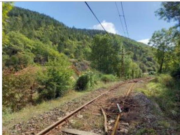
Vue du site, auteur: OTEIS, 2023
