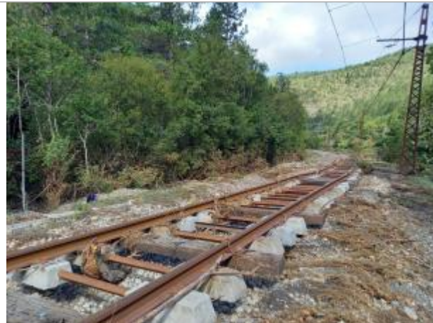
Vue du site, auteur: OTEIS, 2023
