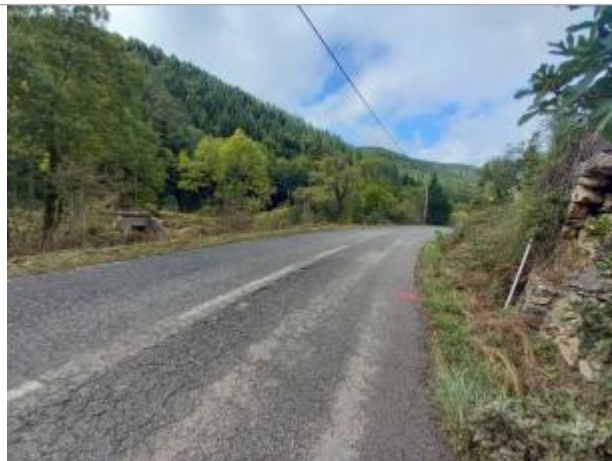
Vue du site, auteur: OTEIS, 2023
