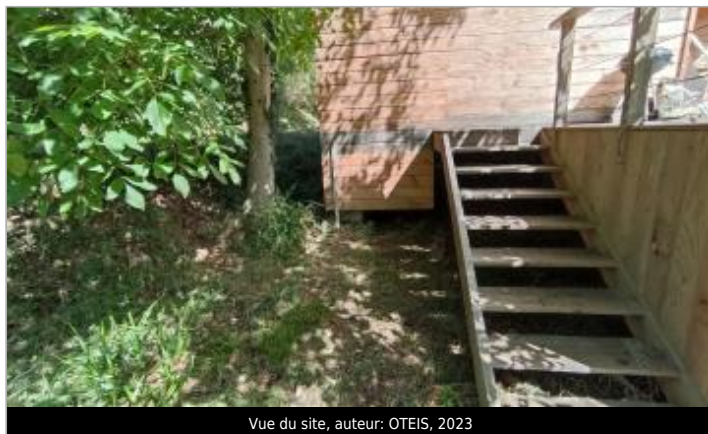
Vue du site, auteur: OTEIS, 2023
