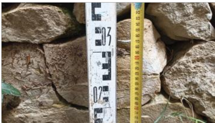
Vue du repère, auteur: OTEIS, 2023
