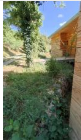
Vue du site, auteur: OTEIS, 2023
