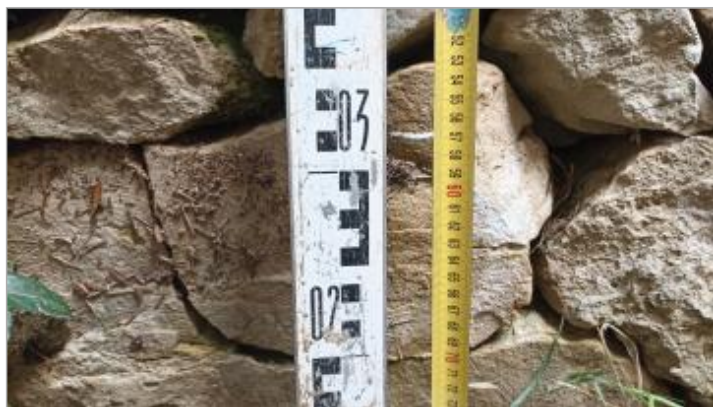
Vue du repère, auteur: OTEIS, 2023
