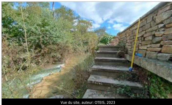
Vue du site, auteur: OTEIS, 2023
