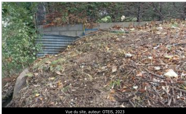
Vue du site, auteur: OTEIS, 2023
