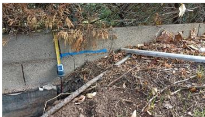
Vue du repère, auteur: OTEIS, 2023
