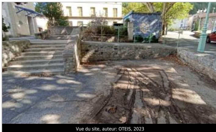
Vue du site, auteur: OTEIS, 2023
