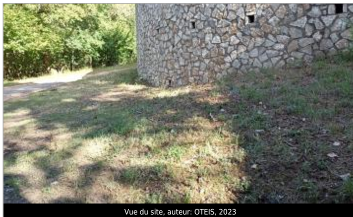
Vue du site, auteur: OTEIS, 2023
