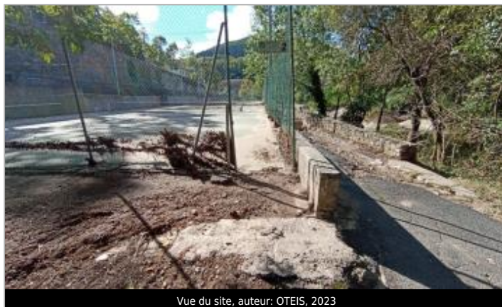
Vue du site, auteur: OTEIS, 2023
