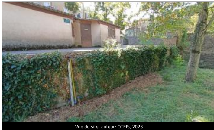
Vue du site, auteur: OTEIS, 2023
