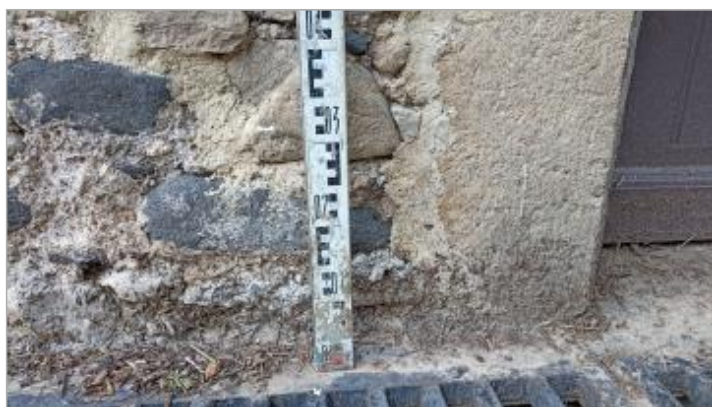
Vue du repère, auteur: OTEIS, 2023
