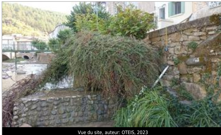
Vue du site, auteur: OTEIS, 2023
