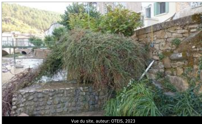
Vue du site, auteur: OTEIS, 2023
