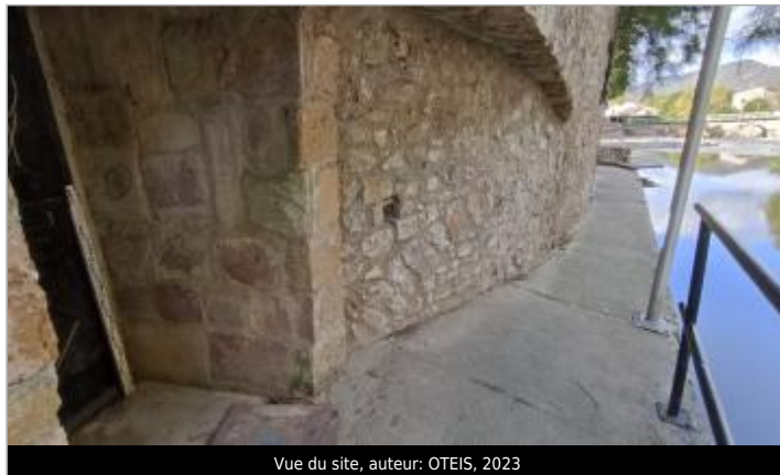
Vue du site, auteur: OTEIS, 2023
