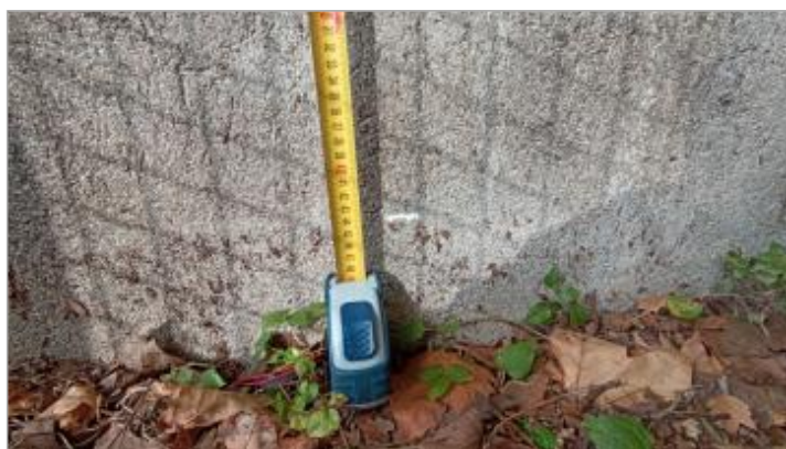
Vue du repère, auteur: OTEIS, 2023
