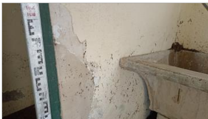
Vue du repère, auteur: OTEIS, 2023
