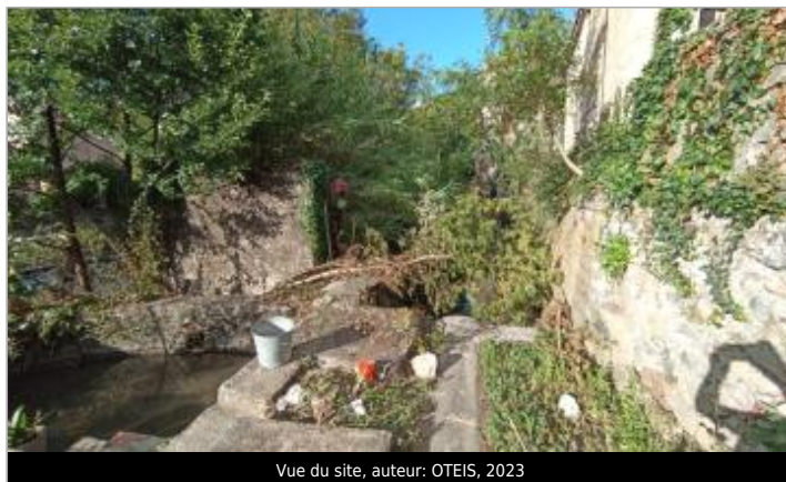
Vue du site, auteur: OTEIS, 2023
