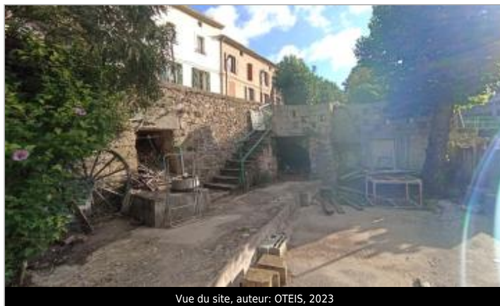
Vue du site, auteur: OTEIS, 2023
