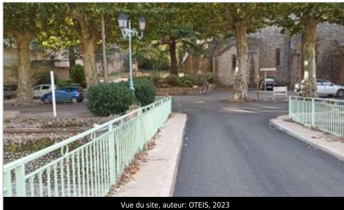
Vue du site, auteur: OTEIS, 2023
