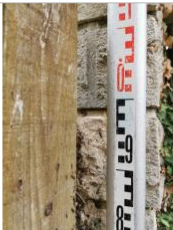
Vue du repère, auteur: OTEIS, 2023
