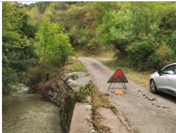
Vue du site, auteur: OTEIS, 2023
