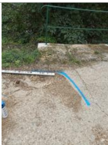
Vue du repère, auteur: OTEIS, 2023
