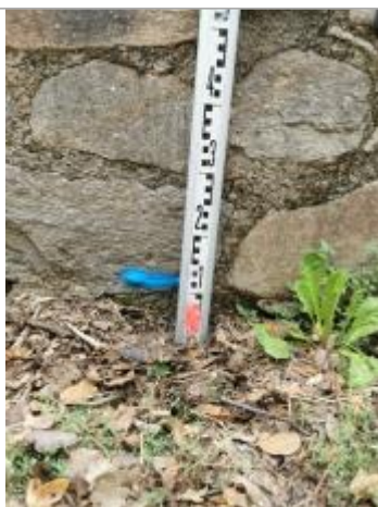
Vue du repère, auteur: OTEIS, 2023
