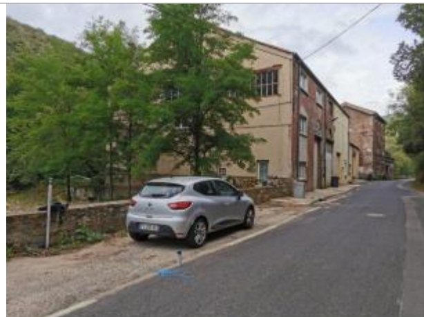
Vue du site, auteur: OTEIS, 2023
