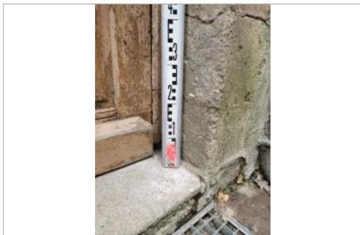
Vue du repère, auteur: OTEIS, 2023
