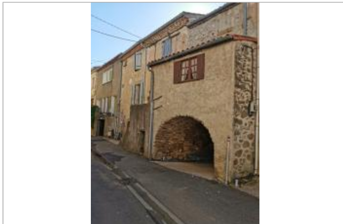
Vue du site, auteur: OTEIS, 2023
