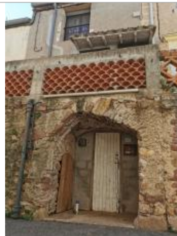
Vue du site, auteur: OTEIS, 2023
