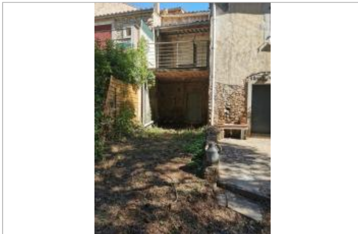
Vue du site, auteur: OTEIS, 2023
