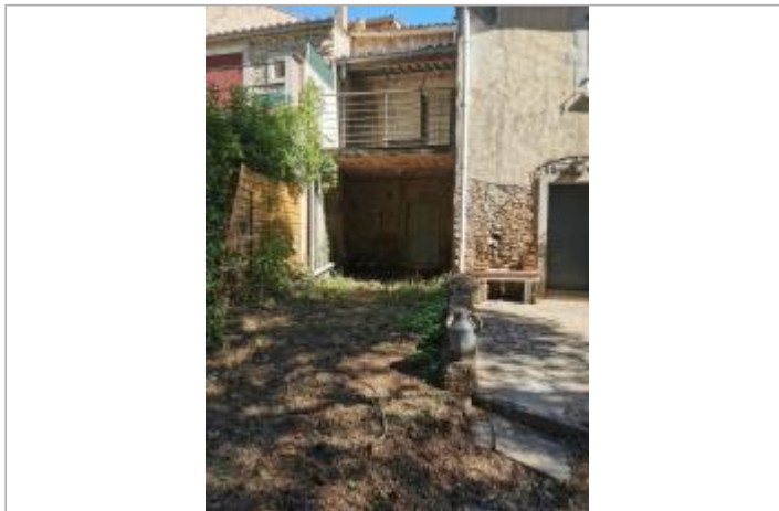
Vue du site, auteur: OTEIS, 2023
