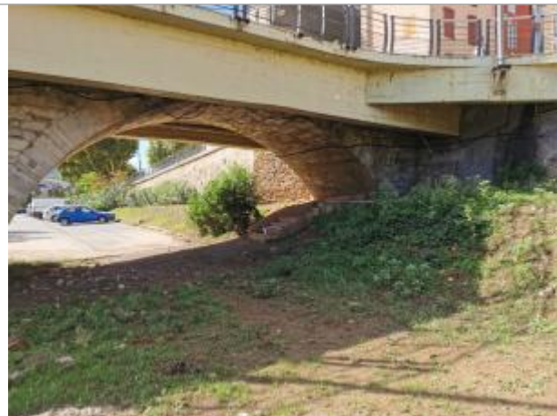
Vue du site, auteur: OTEIS, 2023
