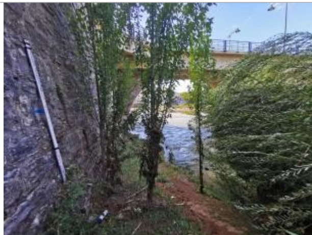
Vue du site, auteur: OTEIS, 2023
