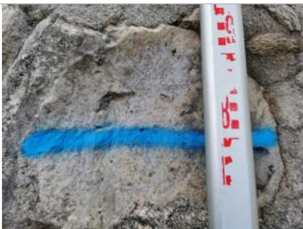
Vue du repère, auteur: OTEIS, 2023
