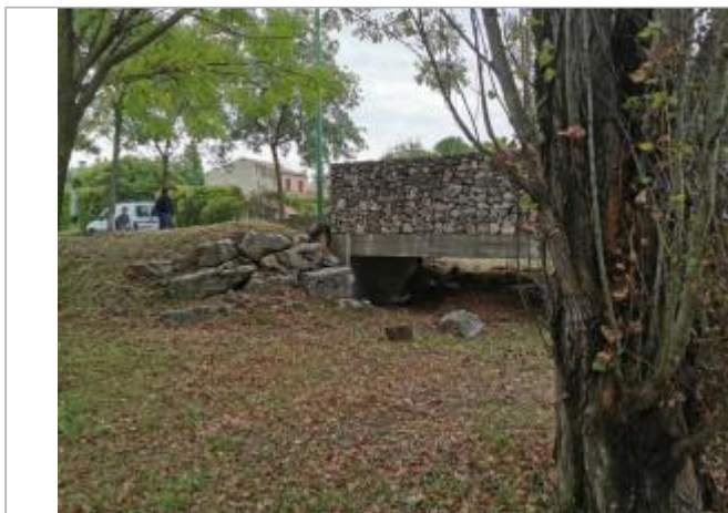
Vue du site, auteur: OTEIS, 2023
