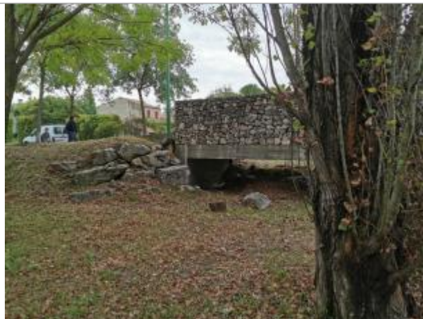
Vue du site, auteur: OTEIS, 2023
