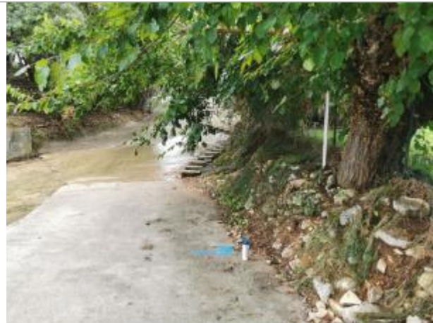
Vue du site, auteur: OTEIS, 2023
