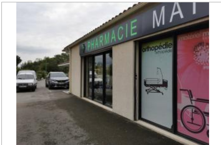
Vue du site, auteur: OTEIS, 2023
